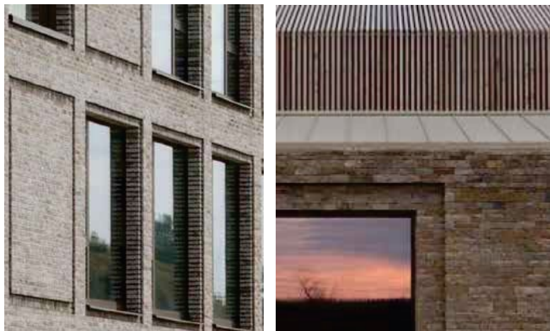
Eksempel på recesdetaljer og træbeklædning
